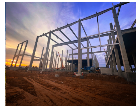
Logistikzentrum LIDL Bravantice 2024, CZ
