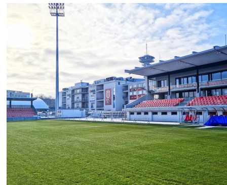
Wiederaufbau des Fußballstadions Parubice 2022, CZ
